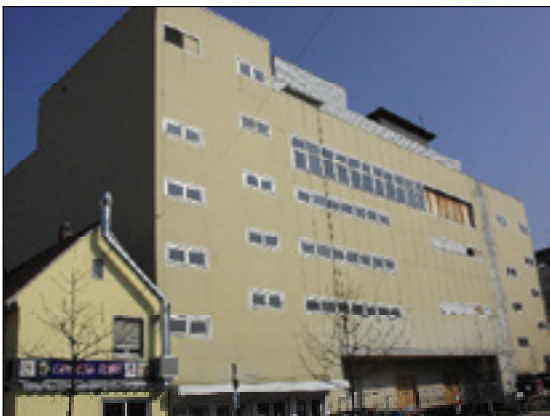
Karstadtgebäude - Rückansicht (Abb. 03)
