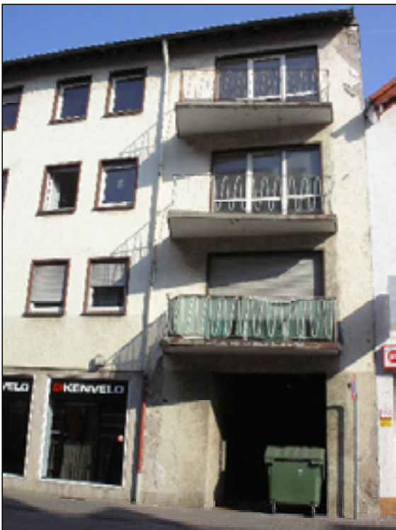
Geschäftshaus in der Alten Post Straße (Abb. 06)
